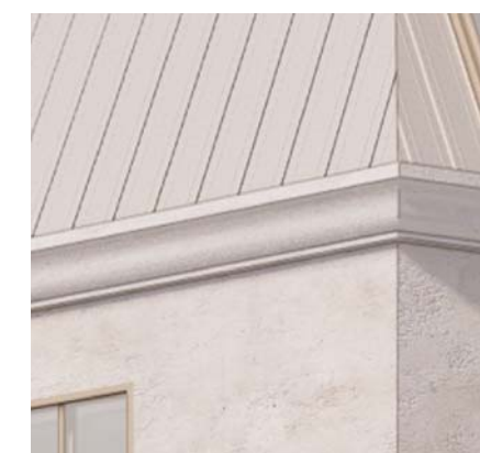
Detail korunní římsy
